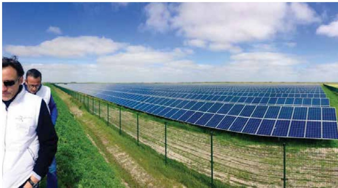
23.000 zonnepanelen voorzien Ameland van elektriciteit zonder CO 2 .
