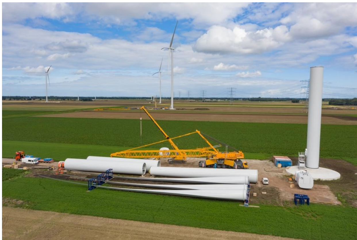
Een windmolenpark in aanbouw.
